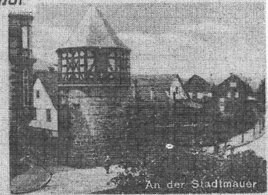
An der Stadtmauer
